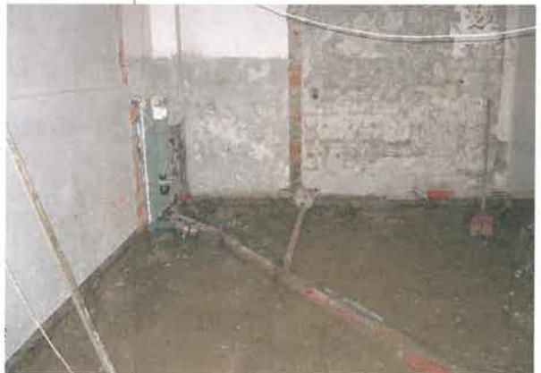
Wasserundurchlässiger Beton (WU-Beton) ersetzte den Ziegelboden, eine Kapillarsperre stoppte die Durchfeuchtung.
