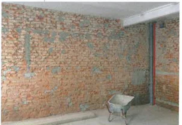
Keine normale Ziegelwand, sondern eine Innendämmung aus mit dem Vulkangestein Perlit gefüllten, extra schmalen Ziegeln.
